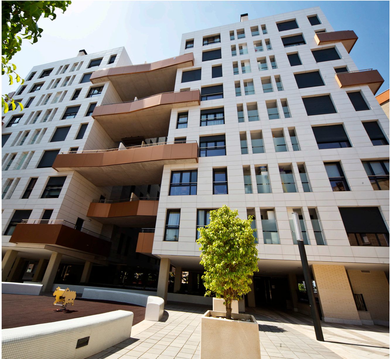
Fachada Ronda Norte Murcia - Spain Metropol Systems
